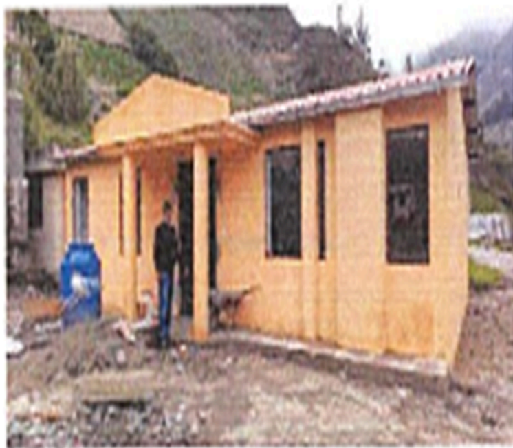
Seguimiento y verificación de la construcción
